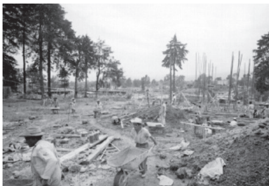
Construcción de la Unidad Independencia, Fototeca Nacional del INAH/Sinafo, fondo Archivo Casasola, núm. de inventario 297841, 1959.
